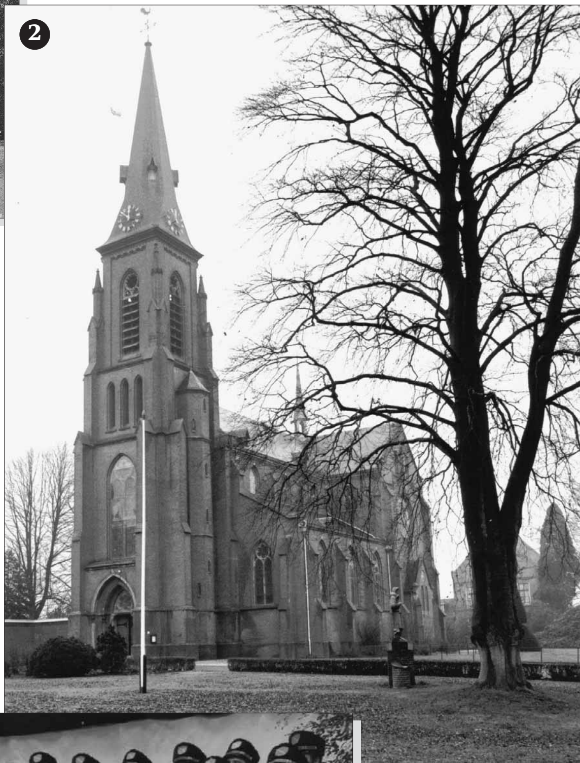
2. Kranenburg, renovatie R.K. kerk.
